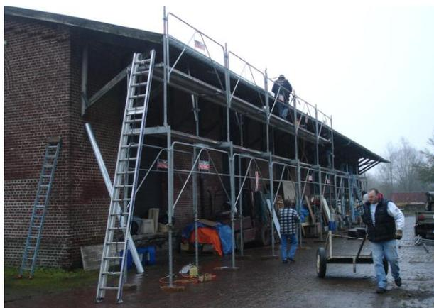
La toiture de la halle de gare a été refaite pour moitié (277 m<sup>2</sup>) à cause de la tempête de grêles de juin 2011. Les vieilles tôles en éternit n'ayant pas résisté. Idem pour la toiture du chalet (164 m<sup>2</sup>)
