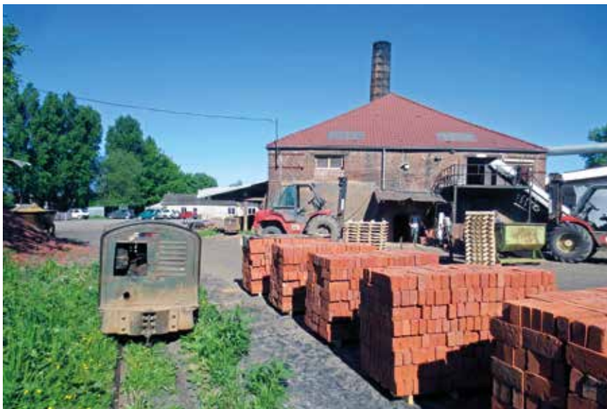
La briqueterie Chimot au temps de sa production, au fond le four Hoffmann.
