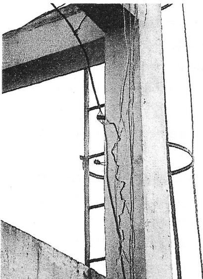
Le château d'eau existant menace de s'effondrer sur les bâtiments à proximité et par voie de conséquence de priver d'eau toutes les structures de la Mission. En effet, des fissures apparaissent au niveau des piliers soutenant la cuve du château. Ces fissures sont si profondes que les fers à bétons sont littéralement rongés par la rouille.
