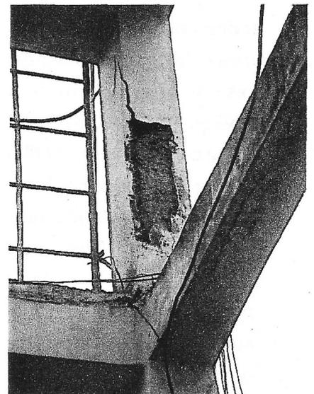
Cela est dû à la mauvaise qualité du sable utilisé à l'époque d'une part et aux vibrations causées par le dynamitage d'une carrière de pierre située à proximité du Centre de l'Espérance en contre-bas du terrain de la Mission d'autre part.
